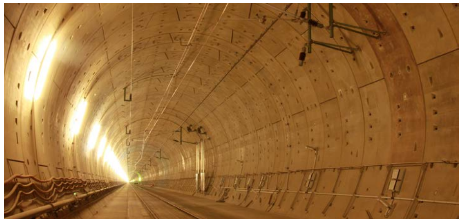
Tunnel mit Innenschalung aus Tübbingringen (Beispiel Katzenbergtunnel)
