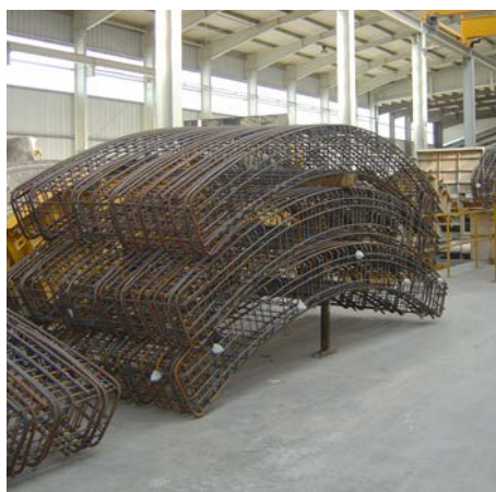
Das Innenskelett der Tübbinge: Bewehrungen aus Stahl
