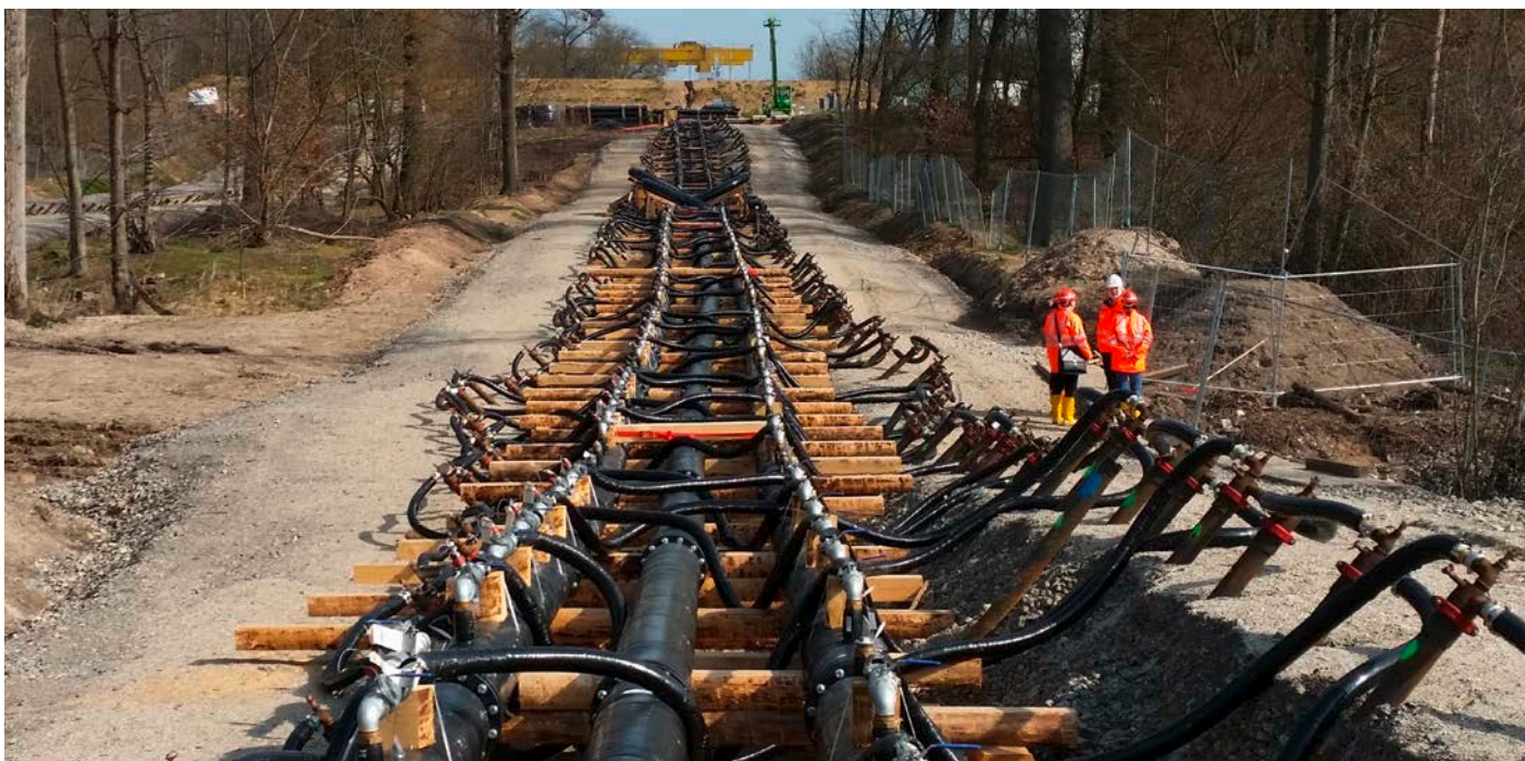
Durch Gefrierbohrungen kann das umliegende Erdreich für den Tunnelvortrieb stabilisiert werden.
