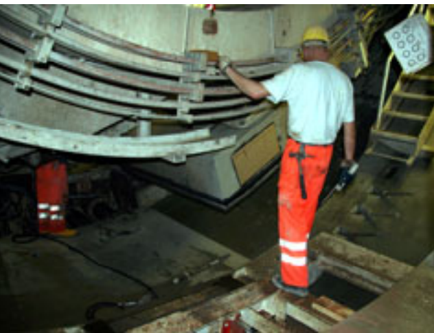
Im Schutz des Schildes der Tunnelvortriebsmaschine werden die Tübbinge mit dem Erektor eingebaut
