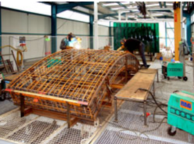
Herstellung der Bewehrungskörbe für die Tübbinge
