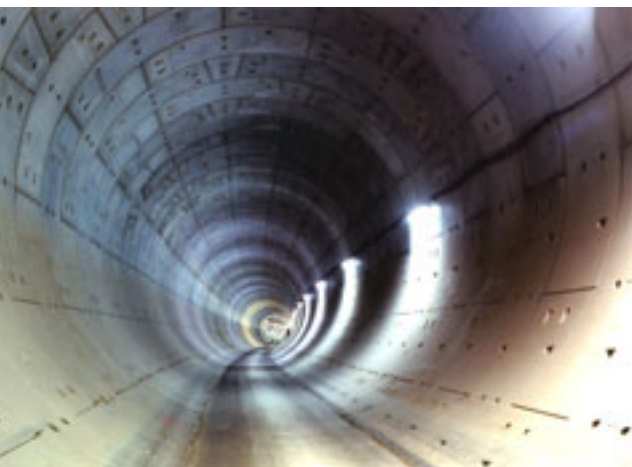
Fertige Tunnelröhre im Rohbau
