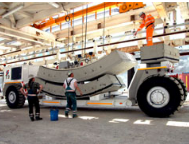
Verladung der Tübbinge auf den Spezialtransporter
