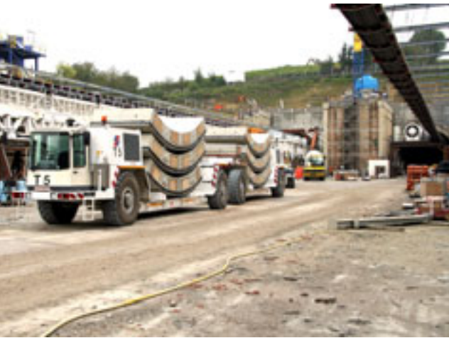
Transport der Tübbinge in den Tunnel
