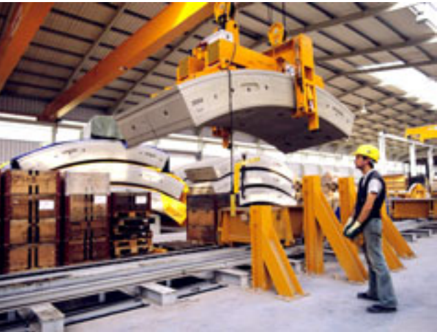
Mit Vakuum-Saugplatten werden die fertigen Tübbingelemente aus der Schalung gehoben
