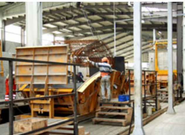
Der Bewehrungskorb wird in die Tübbingschalung eingebracht
