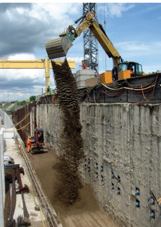
Nordportal: Verfüllung zwischen Grundwasserwanne und Tunnelröhre.
