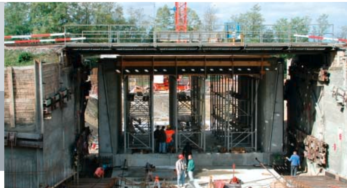
Eisenbahnüberführung am Nordportal, unter der künftig die Straße zum Rettungsplatz Nord verläuft
