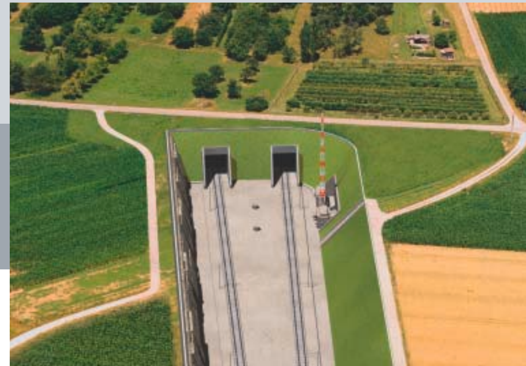
Das Südportal des Katzenbergtunnels, der als Zwei-Röhrentunnel gebaut wird
