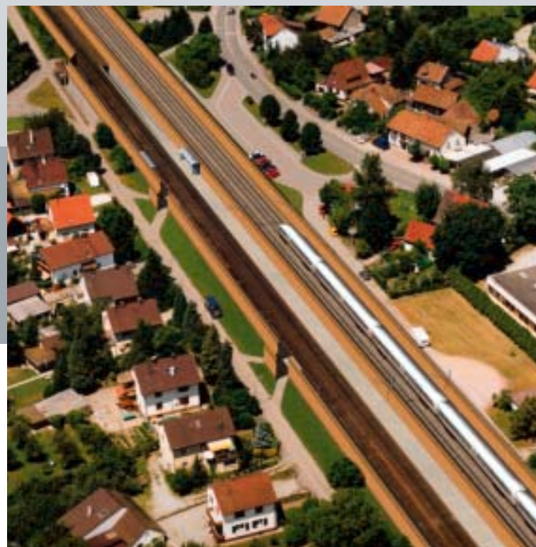
... und Anpassung der Bahnsteige in Eimeldingen
