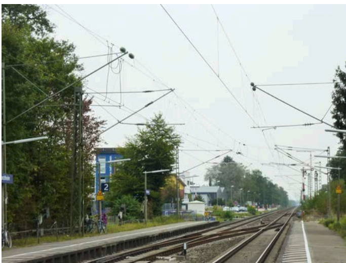
Am Bahnhof Forchheim werden ebenfalls Bauarbeiten durchgeführt.
