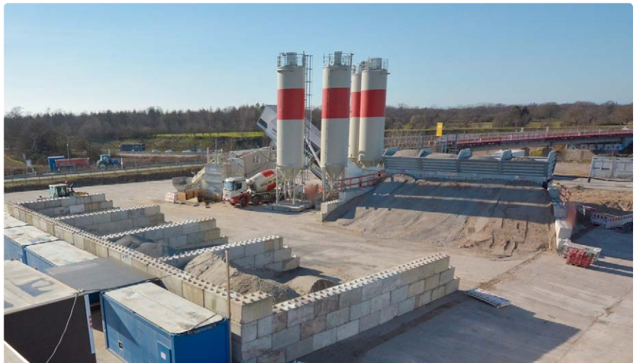
Baustelleneinrichtungsfläche Ötigheim: Hier wird frischer Beton für den Innenausbau produziert.
