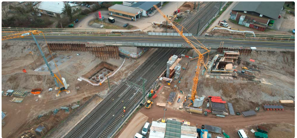
An der B 378 steht bereits der erste Pfeiler westlich der Gleise.
