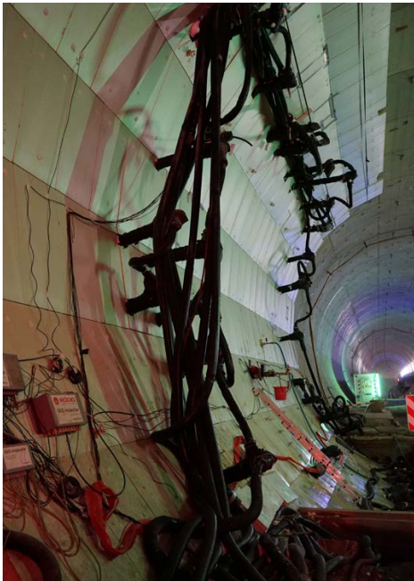
An der Tunnelröhre sind die Gefrierlanzen ...
