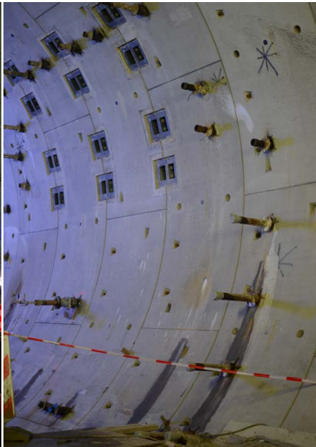
... als Vorbereitung der Gefrierbohrungen angebracht.
