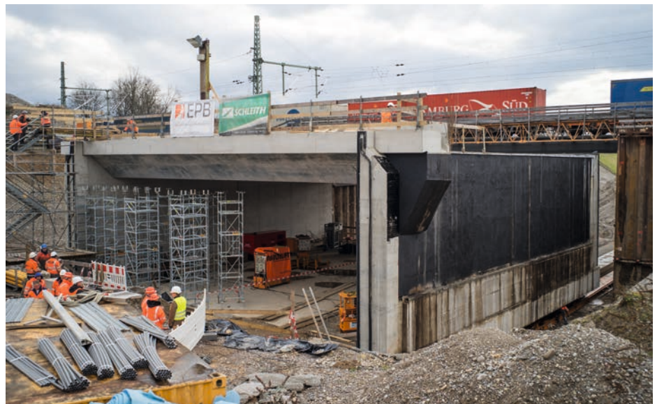
Der Schienenverkehr konnte während des Verschubs ohne Einschränkungen aufrechterhalten werden.
