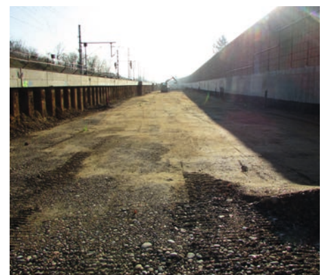
Vorbereitung der Baufläche
