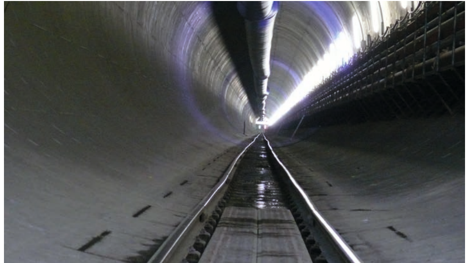
Blick in die Weströhre des Tunnels Rastatt
