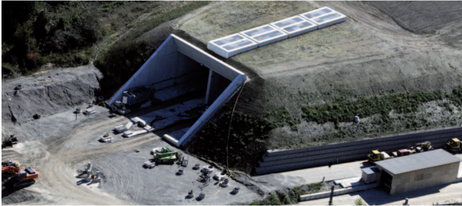
Das Sonic Boom-Bauwerk am Nordportal des Katzenbergtunnels.
