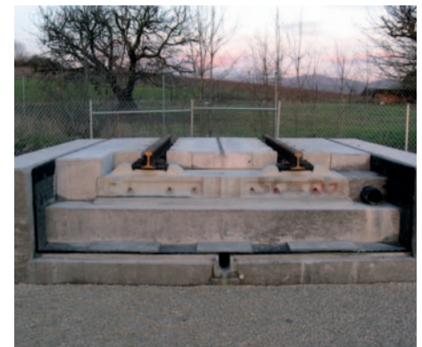
Dieses Exponat zeigt die Feste Fahrbahn und das Erschütterungsschutzsystem.
