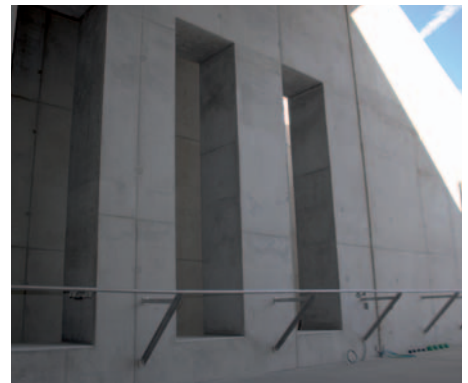
Die seitlichen Öffnungen des Haubenbauwerks ermöglichen den Druckausgleich.
