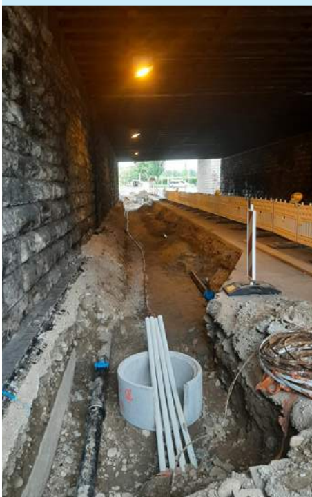
Verlegung der Kabeltrasse in der Neuhausstrasse
