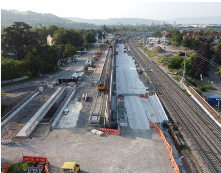
Die neue Eisenbahnbrücke über die Heldelinger Straße und die Straßenbrücke Kanderstraße sind fertiggestellt.
