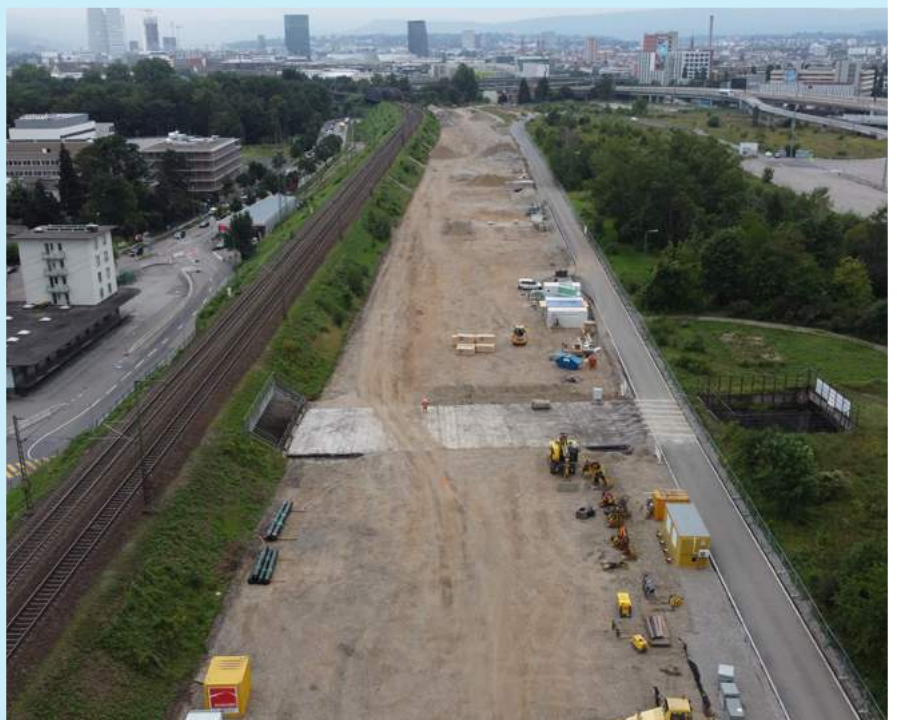
Vorbereitungen für den Rückbau der Brücke
