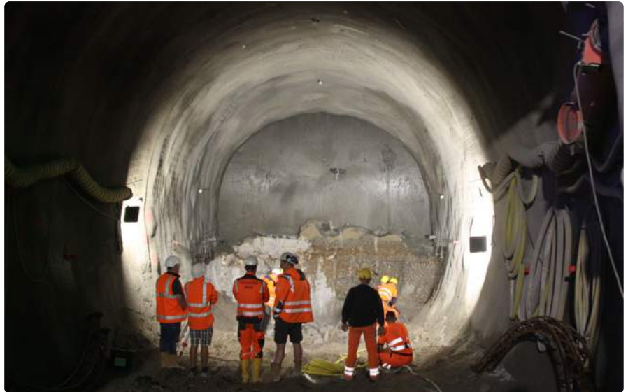
Die Außenschale ist fast fertig.
