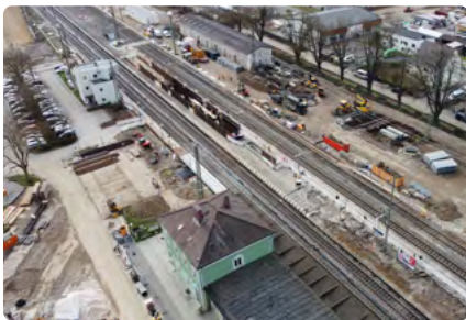
Oben die Baustelle am Bahnhof Müllheim und rechts die westliche Baugrube für die Eisenbahnbrücke über die Parkplatzzufahrt
