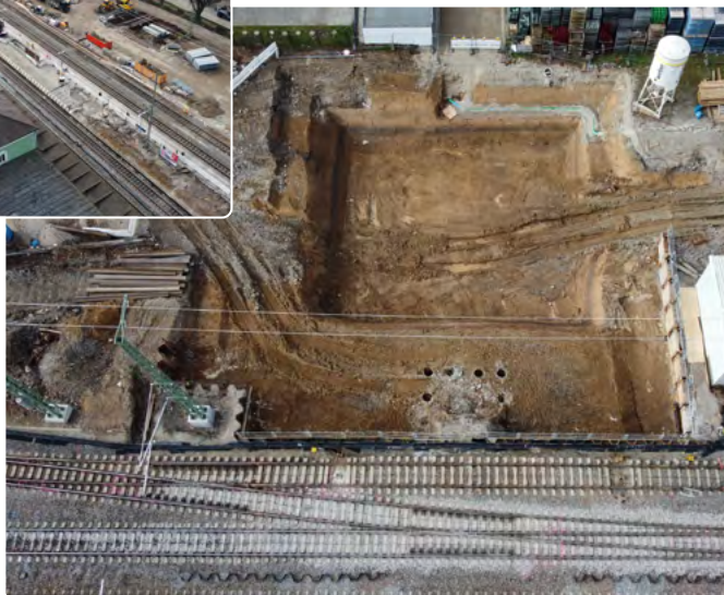
Oben die Baustelle am Bahnhof Müllheim und rechts die westliche Baugrube für die Eisenbahnbrücke über die Parkplatzzufahrt
