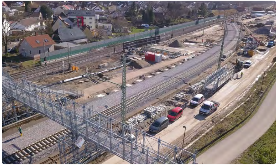
Verlegung der Rheintalbahn in Niederbühl
