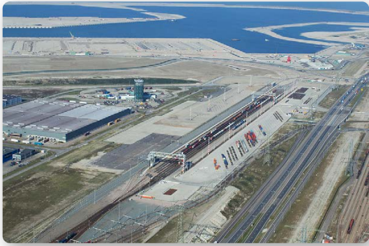
Tor zur Nordsee: der Hafen in Rotterdam, ECT Rail Terminal West, Maasvlakte
