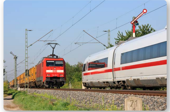
Wichtiger Bestandteil des Korridors: die Rheintalbahn
