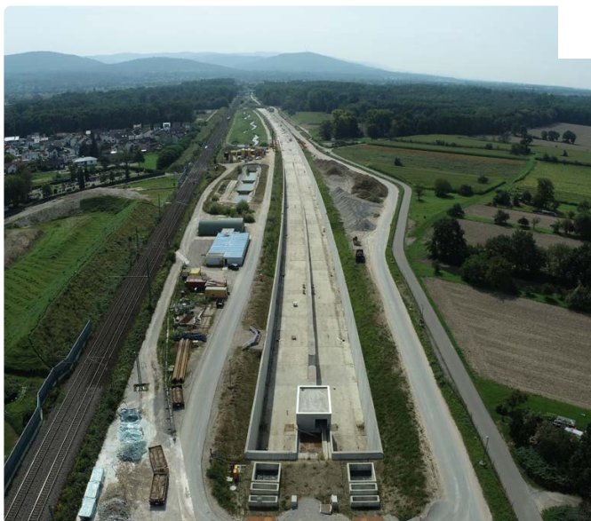
Die Tunnelbaustelle in Rastatt-Niederbühl
