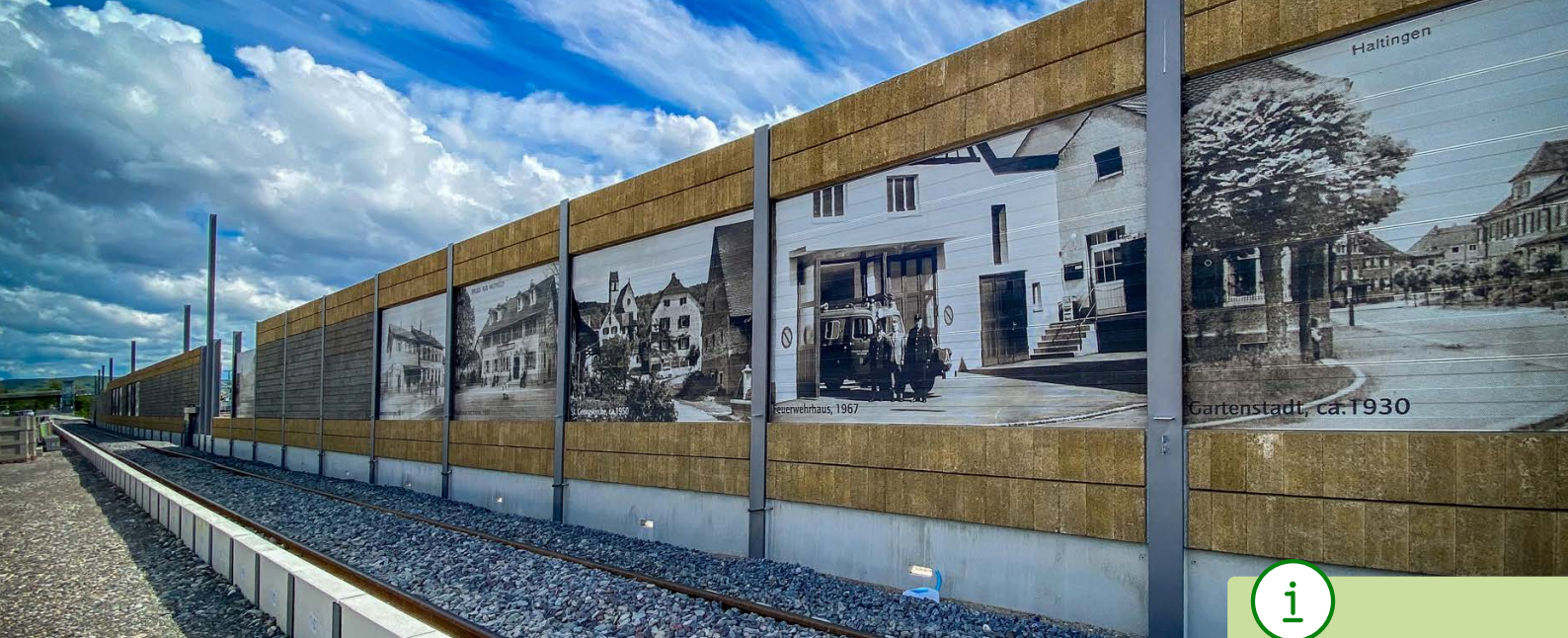
Neue Schallschutzwand in Haltingen
