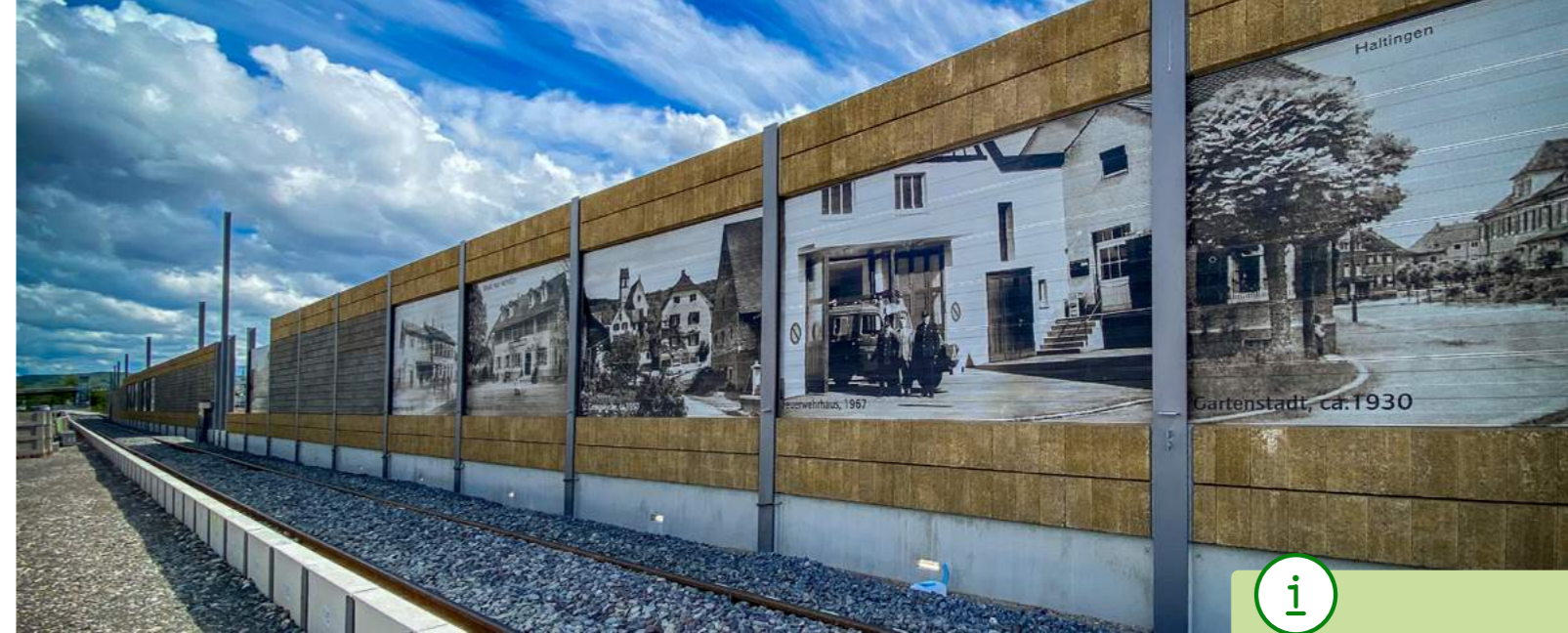
Neue Schallschutzwand in Haltingen
