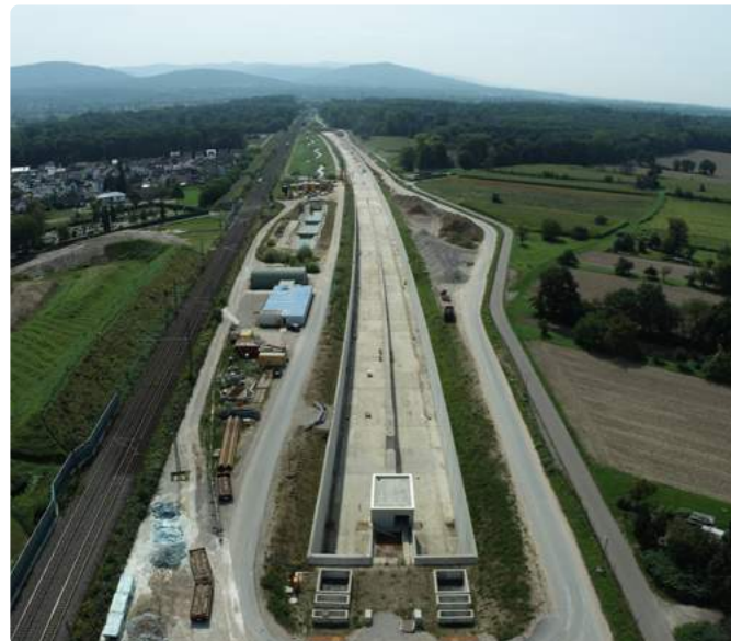
Die Tunnelbaustelle in Rastatt-Niederbühl
