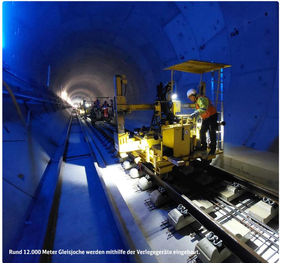
Rund 12.000 Meter Gleisjoche werden mithilfe der Verlegegeräte eingebaut.
