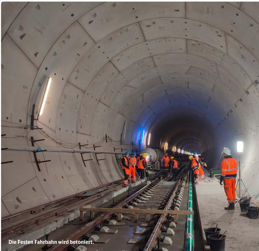
Die Feste Fahrbahn wird betoniert.
