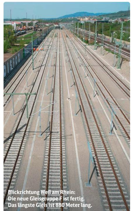
Aktuell sind die Gleisgruppe F und der Badische Bahnhof in Basel über ein provisorisches Anschlussgleis miteinander verbunden. Die hauptverkehrliche Inbetriebnahme der Güterstrecke ist voraussichtlich 2029 abgeschlossen, sodass die Verbindung dann über die zwei Durchfahrtsgleise erfolgt.
