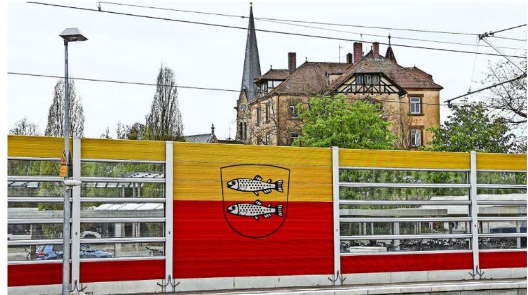
Farbenfroh mit Stadtwappen und transparenten Elementen: Die Schallschutzwände entlang der ICE-Strecke im Bereich des Bahnhofs Forchheim. Foto: /Rost
