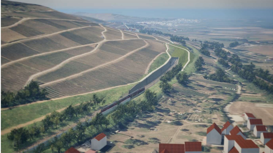
Abbildung 6: Landschaftsbrücke Str 4000 km 213,64+00
