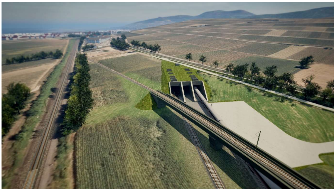
Abbildung 10: Südportal Batzenbergtunnel (Str 4316) und Kreuzungsbauwerk Süd
